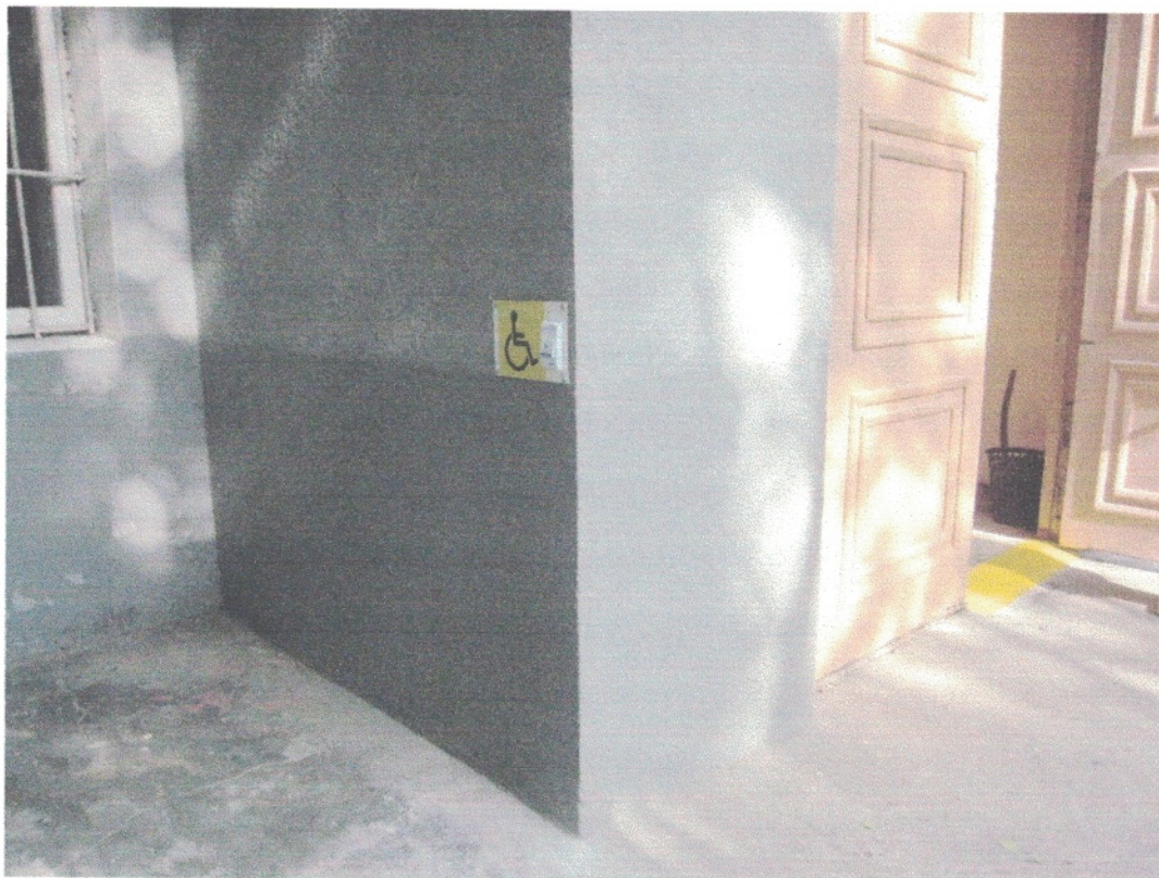
Фото 11. Кнопка виклику персоналу коледжу біля вхідних дверей
