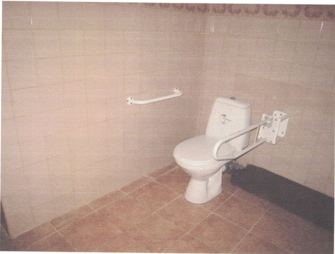
Фото 9. Санвузол з поручнями, в якому передбачений простір для крісла колісного
