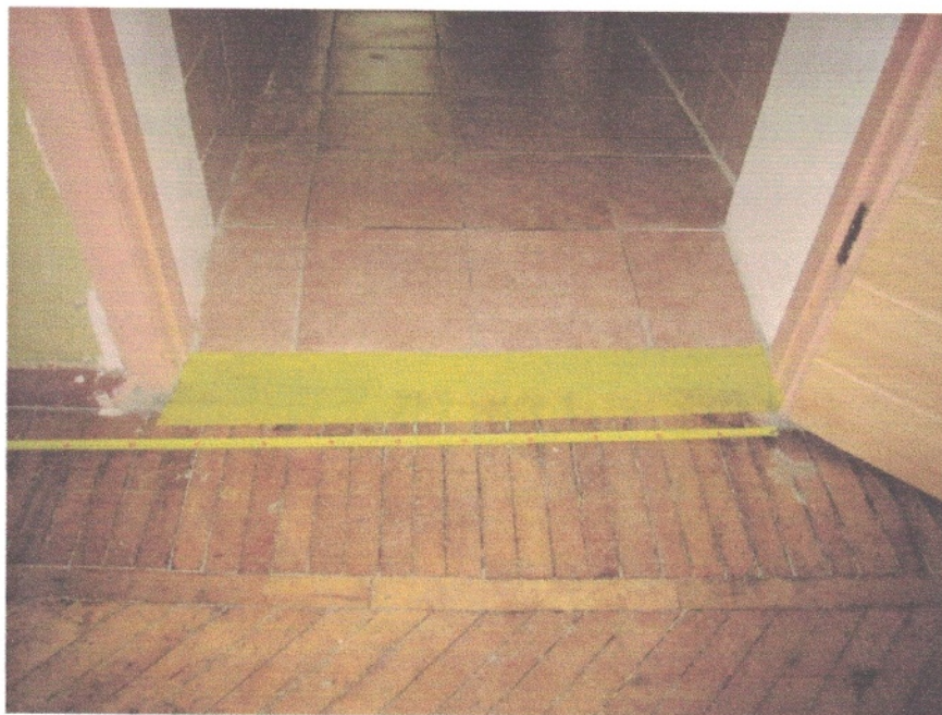
Фото 8. Внутрішні двері без порогів
