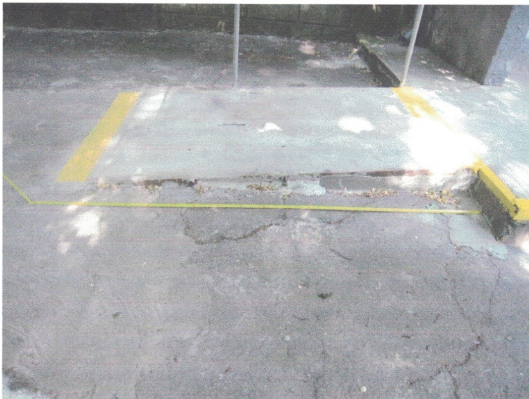
Фото 3. Пандус перед ганком з ухилом 1:12 і маркуванням
