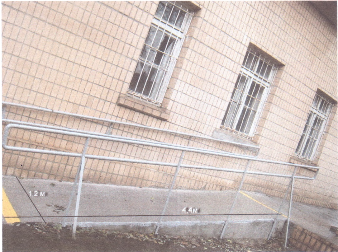
Фото 3. Пандус перед ганком з ухилом 1:12 і маркуванням
