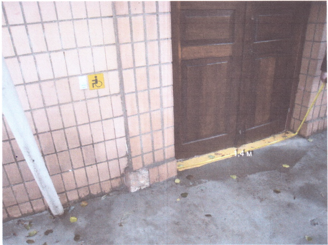
Фото 5. Ширина входних дверей 1,4м. Кнопка для виклику персонала
