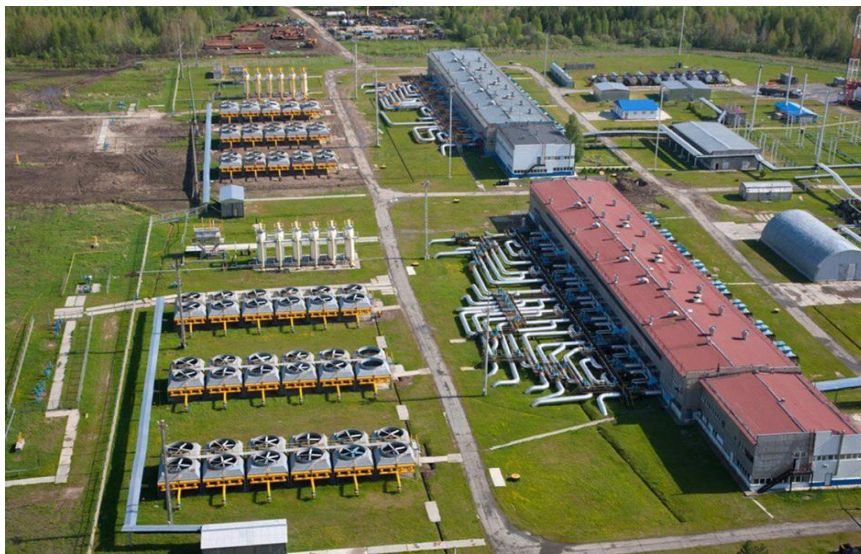
Мал.4. Компресорна станція в загально цеховому укритті
