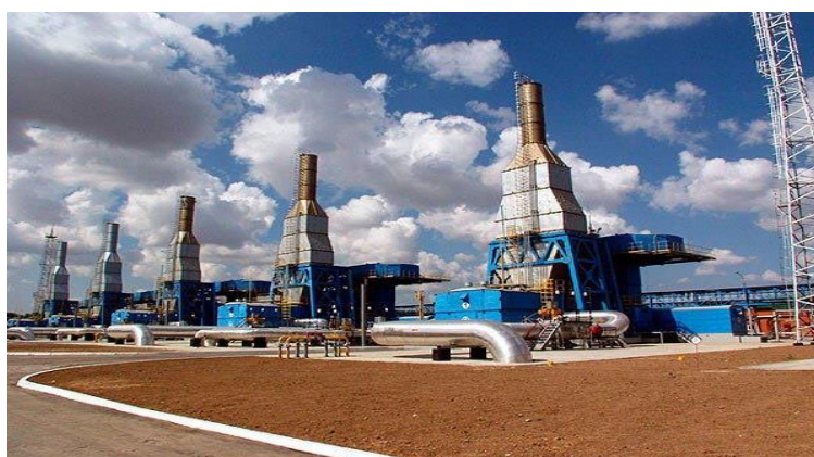
Мал. 2. Газоперекачувальні агрегати в індивідуальному укритті
