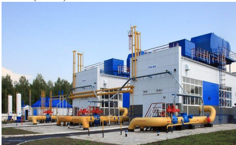
Мал. 1. Газоперекачувальні агрегати в індивідуальному укритті
